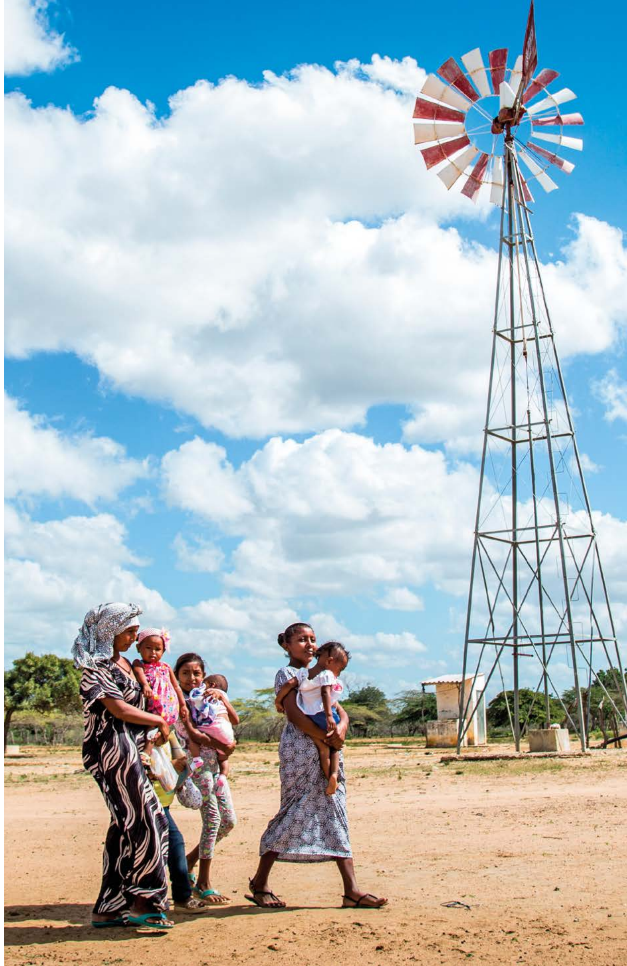
Molinos de viento en el municipio de Manaure (La Guajira) que permiten abastecer de agua a las comunidades
