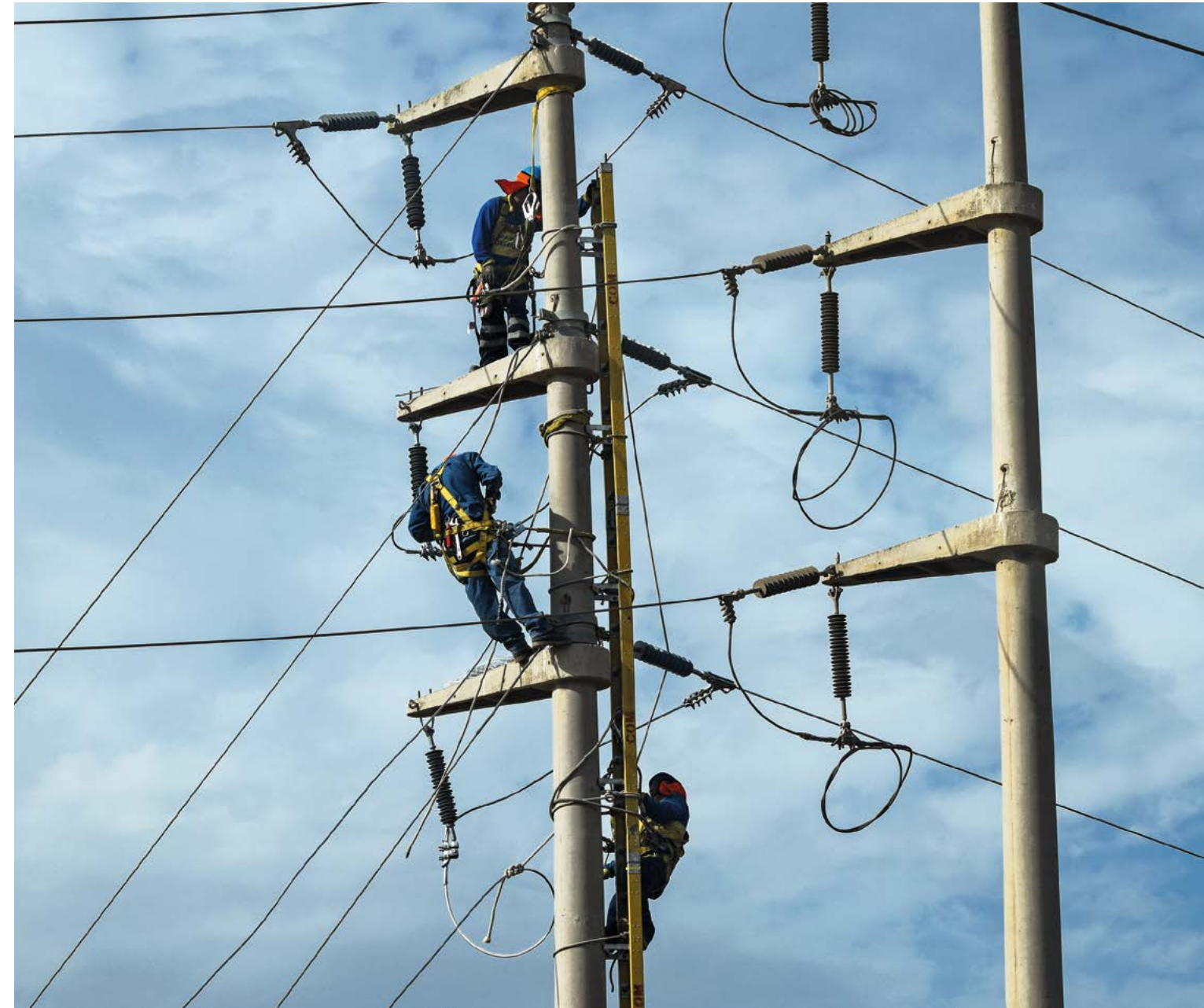
Colaboradores de Electro Dunas realizando mantenimiento en Perú
