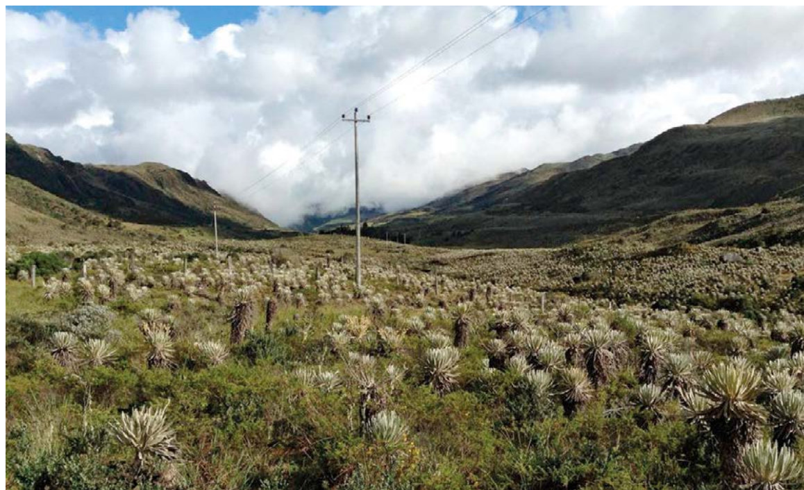
Torre de transmisión en el municipio Filandia, del proyecto Armenia entre los departamentos de Quindío y Risaralda
