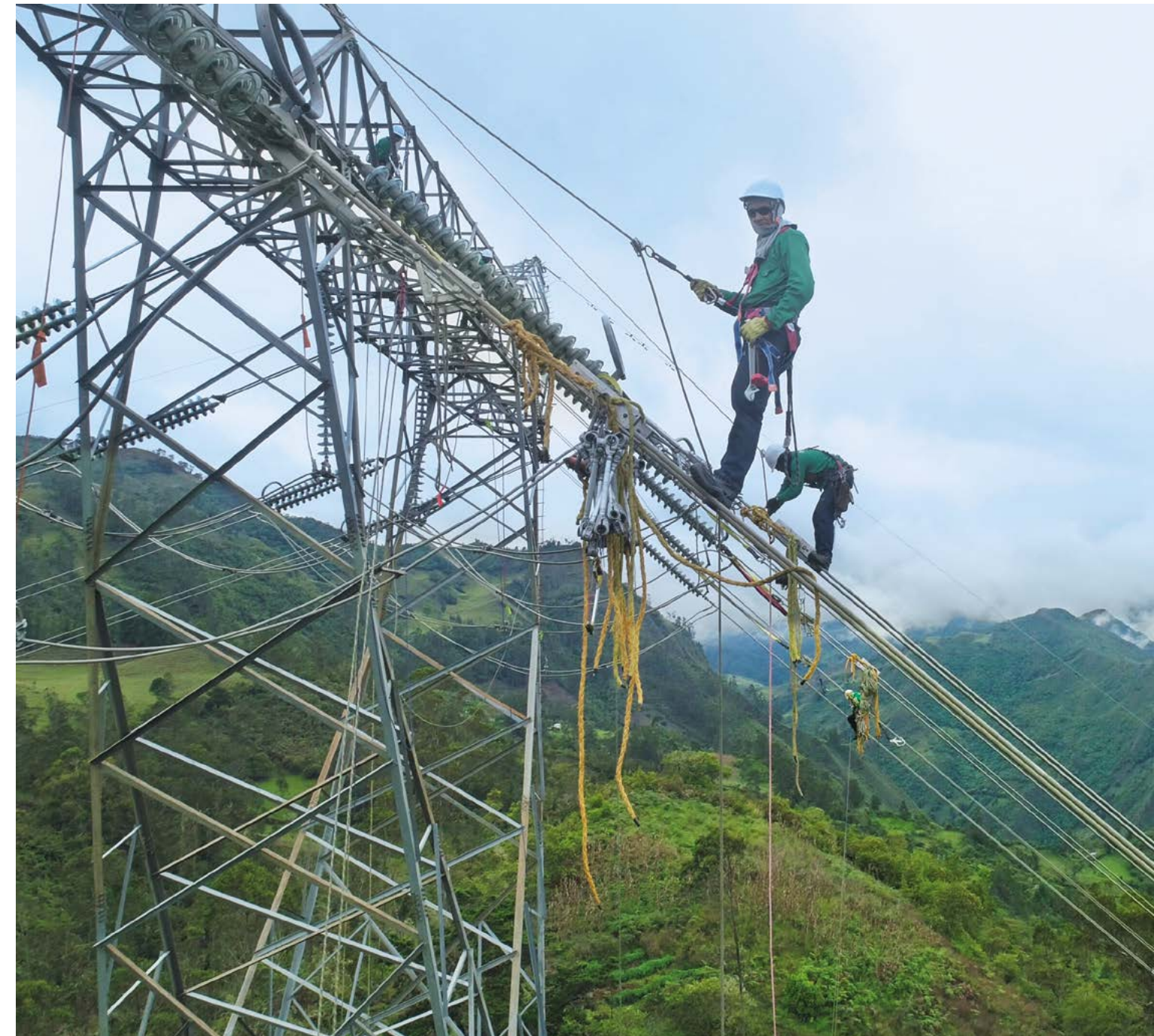
Mantenimiento de líneas de transmisión Circo-Guavio, torre 77
