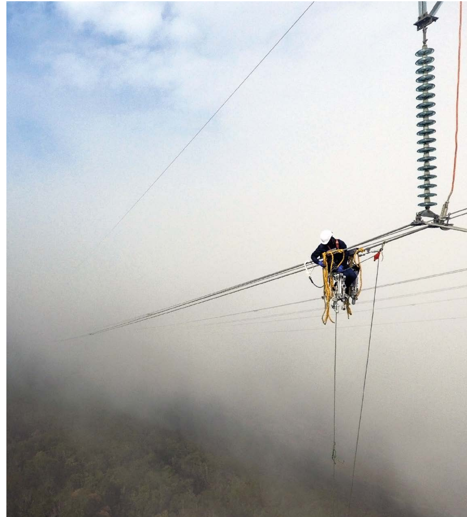
Mantenimiento línea de transmisión en Guasca, Cundinamarca
