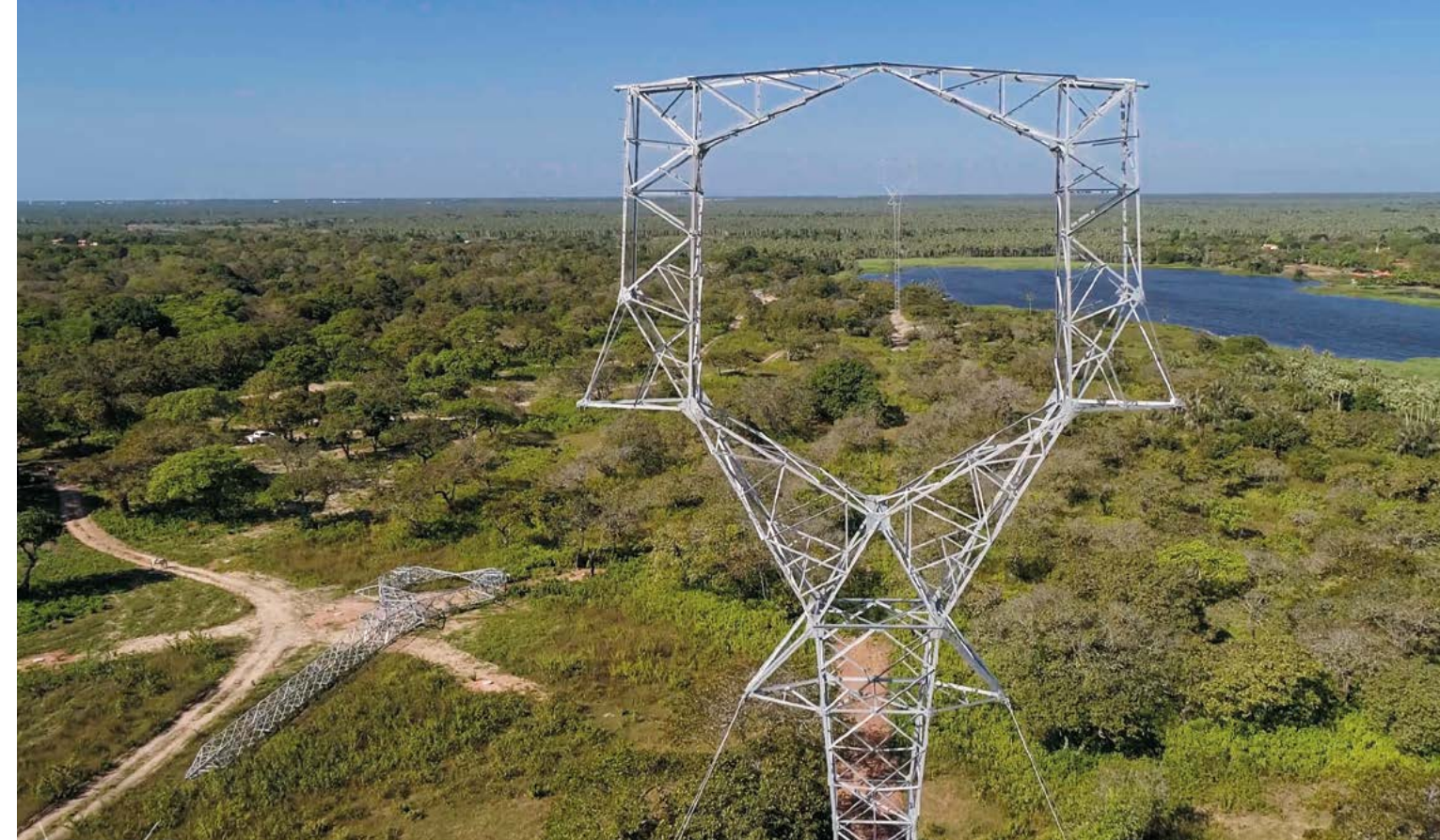
Torre de energía de la compañía brasileña Argo, que está en proceso de adquisición
