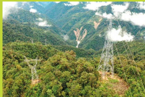
Después de arduas jornadas se levantó la torre que permite que al sur del país le llegue el servicio de energía eléctrica
